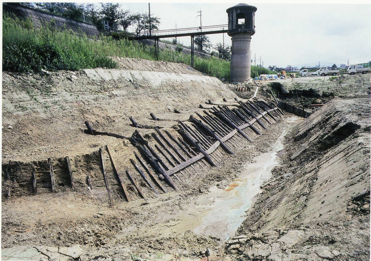
木製樁工全景
