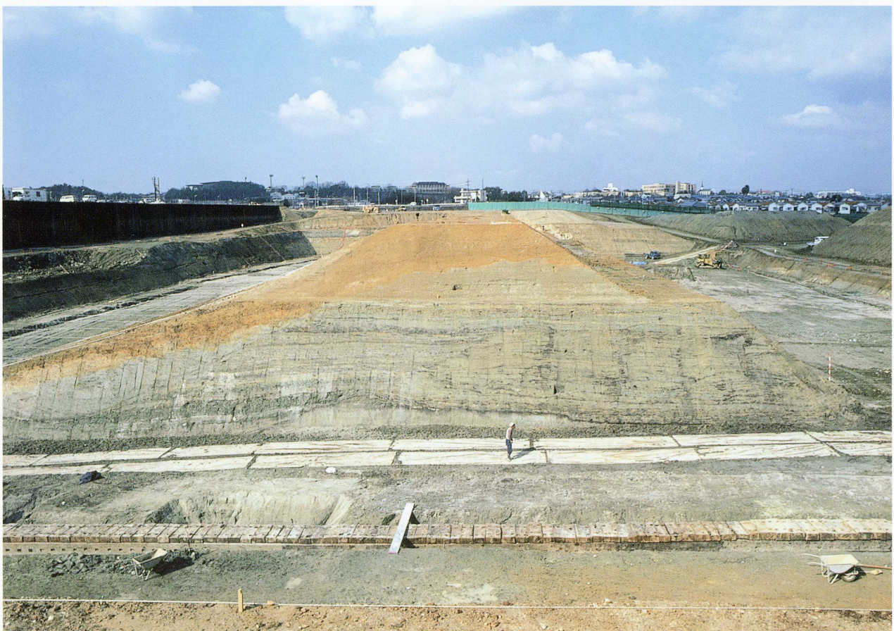
北堤断面全景
